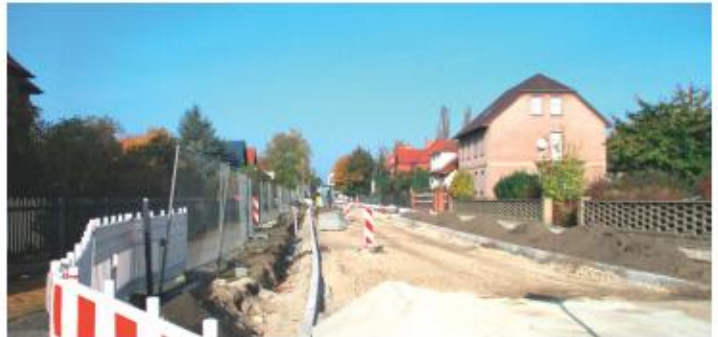
Schützenstraße während der Bauphase
