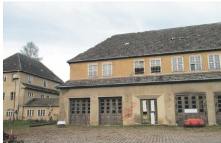
1927 erbaute Wagenhalle, die erhalten bleiben wird
