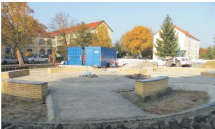
Baumaßnahme Suleciner Platz
